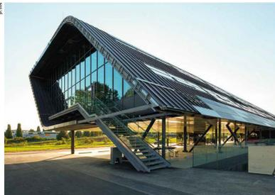
Il risultato è un corpo di fabbrica fluttuante, sospeso su pilastri metallici che liberano lo spazio per un parcheggio esterno e coperto al piano terra. L'accesso all'edificio avviene tramite la scala esterna posta sul lato corto, che aumenta la sensazione di proiezione in avanti della struttura, seguendo l'inclinazione del retinale di 42 gradi.
