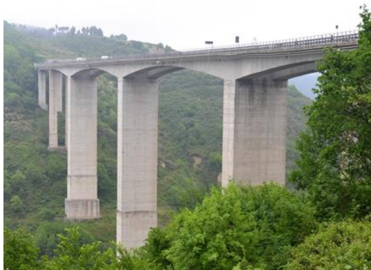
Figura 3 - Viadotto Stupino - Carpanzano (CS), Calabria – Anno di inaugurazione 1974.
