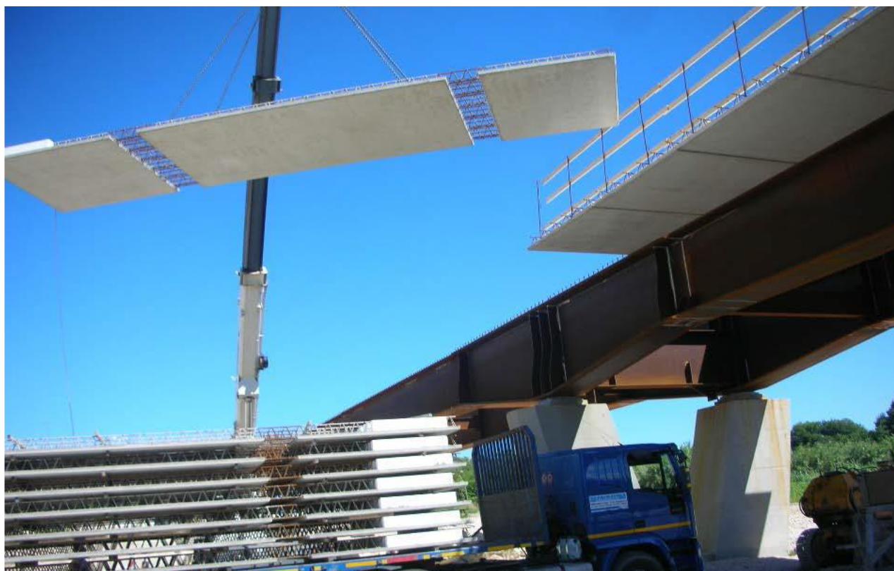
Messa in opera di lastre predalle
