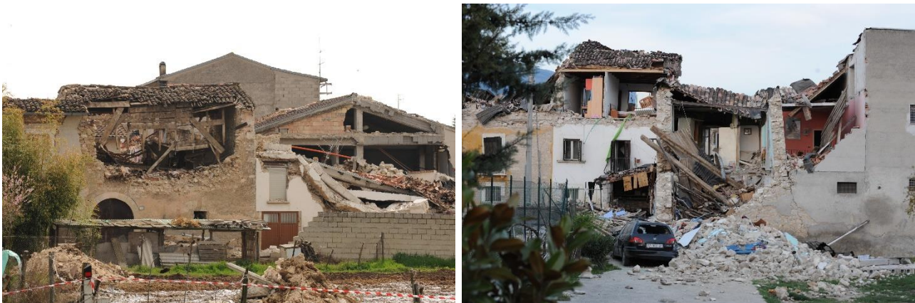
Fig. 5 – Danni a seguito del terremoto in Abruzzo 2009 (Onna, frazione di L'Aquila)
