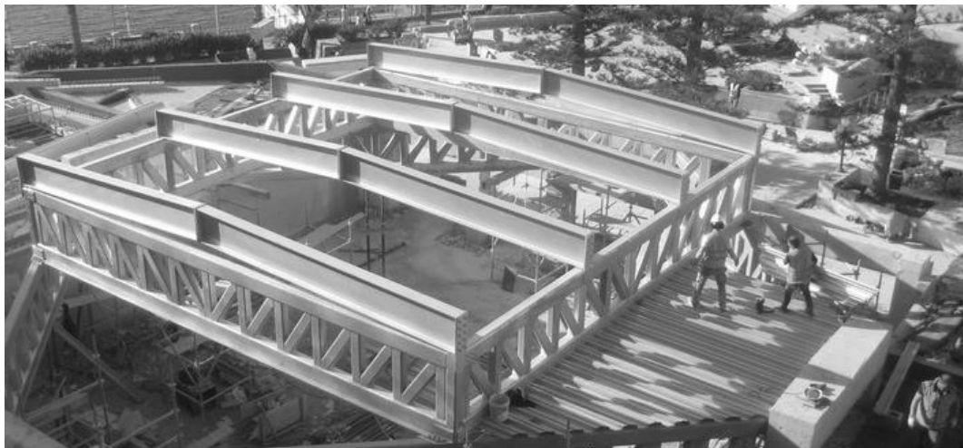
Vista di un cantiere in carpenteria metallica – Foto: Officine Bertazzon spa
