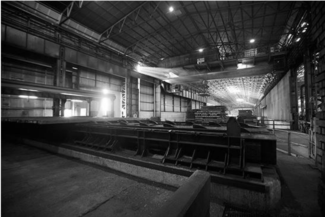
Stabilimento produttivo Ferrosider spa
