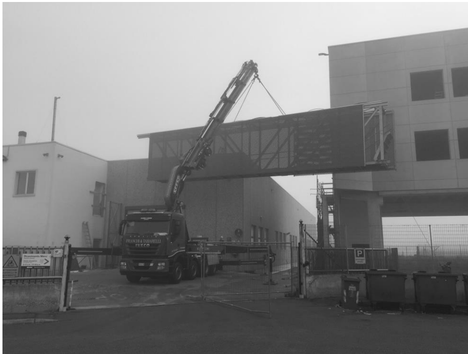
Vista di cantiere – Foto: EFFEVI srl
