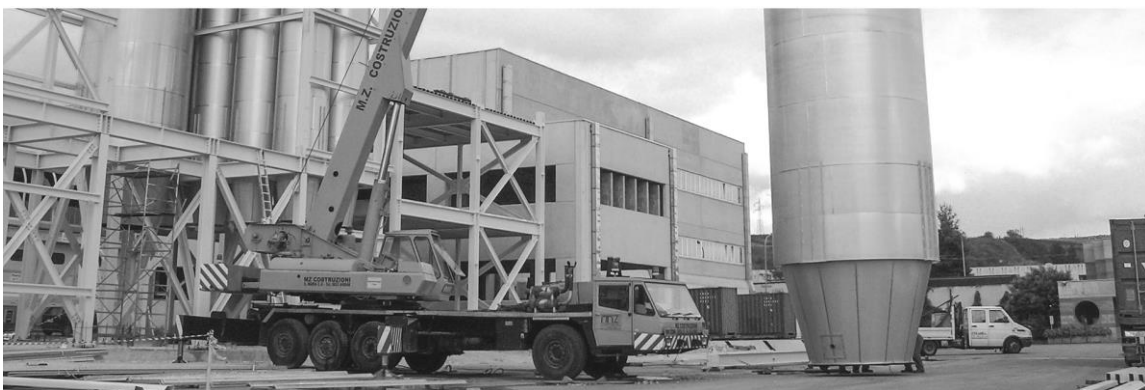
Vista di cantiere – Foto: M.Z. Costruzioni srl
