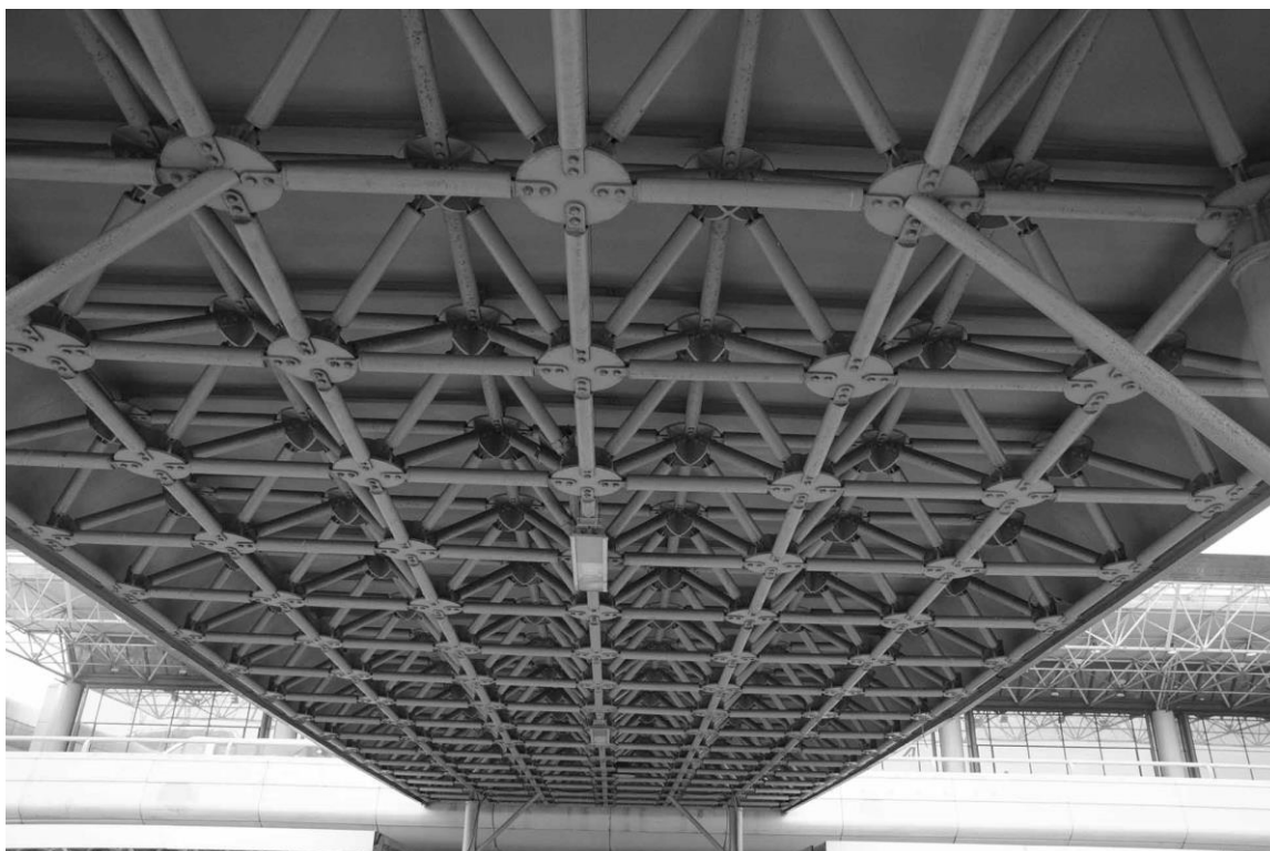
Pensiline Aeroporto di Fiumicino – foto: Ciccotti Lavorazione Metalli srl
