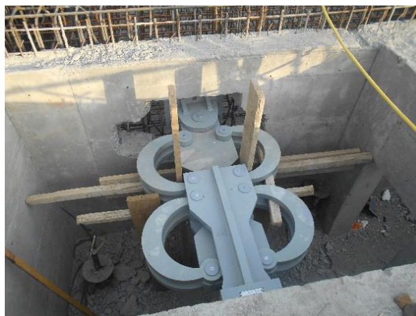
Dissipatore sismico isteretico
