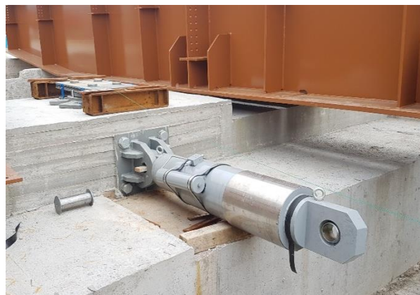
Dissipatore sismico fluidodinamico
