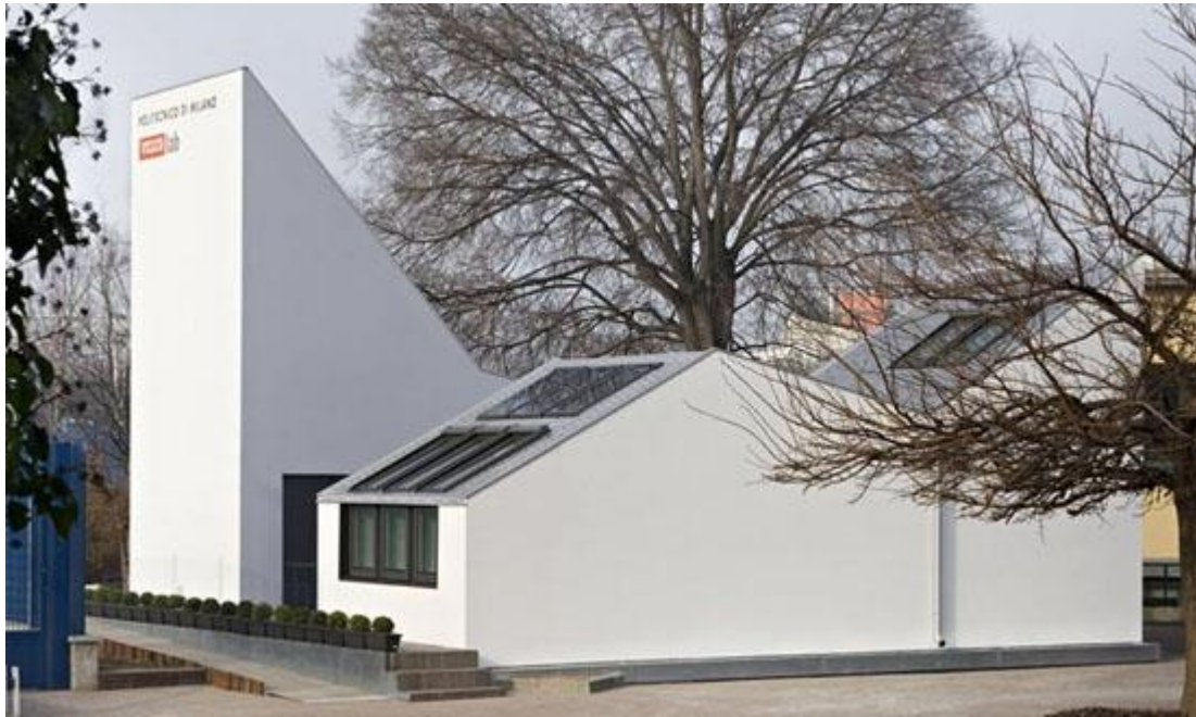
Il "Velux Lab" a cantiere ultimato © Atelier2 Gallotti & Imperadori Associati
