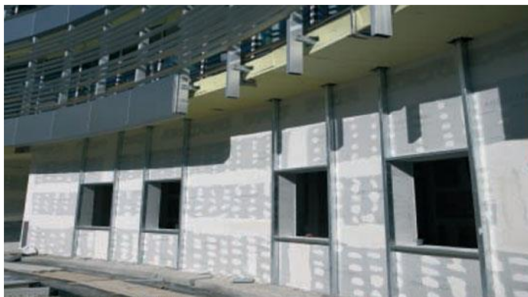
Vista di cantiere della sede ANAS a L'Aquila © Knauf
