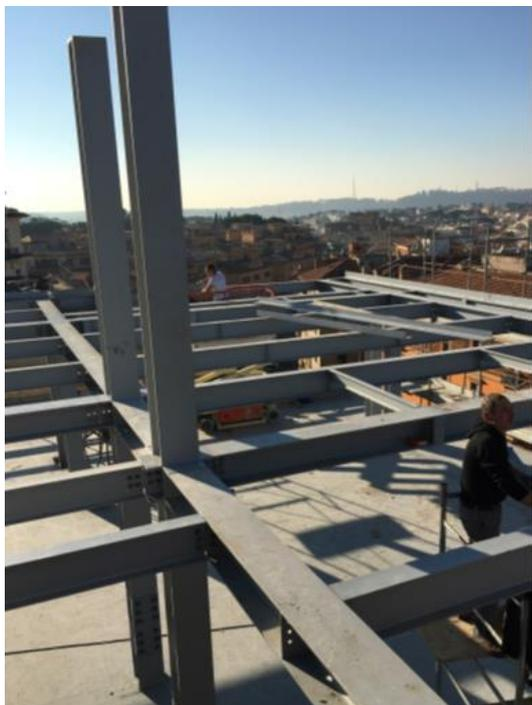
Nell'ipotesi di realizzare il medesimo edificio di 14 piani fuori terra, l'edificio CEMENTO potrebbe essere realizzato in 37 settimane, mentre gli edifici ACCIAIO in 24 settimane, lo scarto dei tempi sarebbe di 13 settimane, pari a circa 3 mesi di guadagno netto per le soluzioni ACCIAIO.
