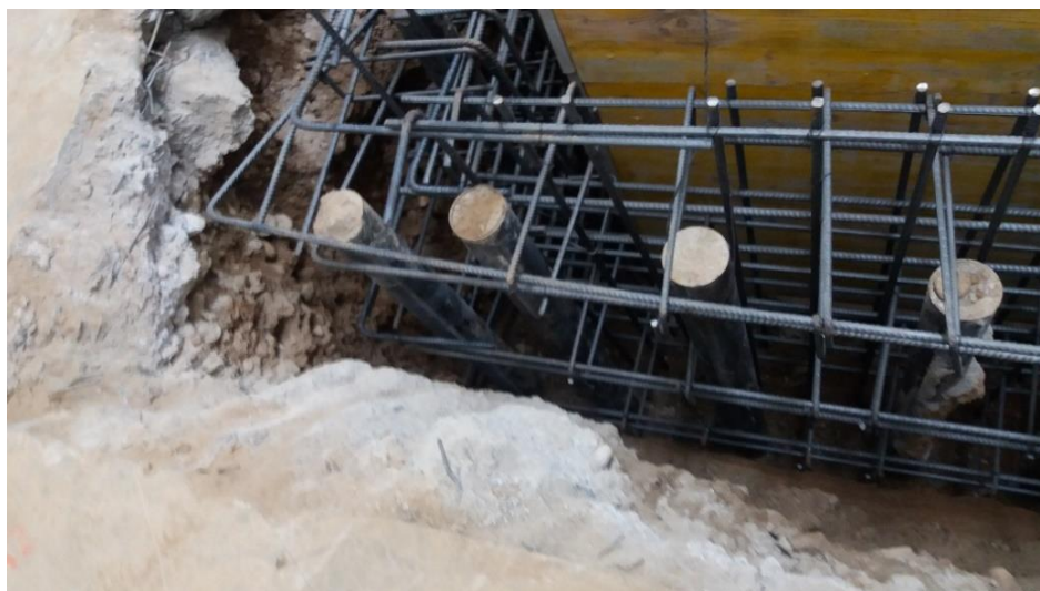
Fig.4 – Micropali già inseriti nel terreno, in fase di realizzazione della trave di coronamento
