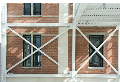
Istituto Falcone - Dettagli delle strutture di controventatura
