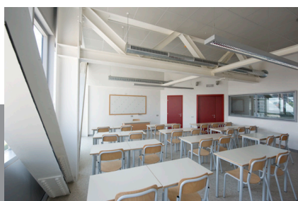
Istituto Falcone - Dettagli delle strutture di controventatura
