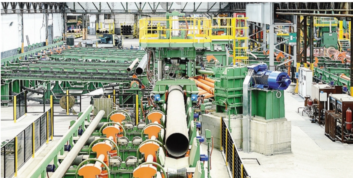
Il nuovo impianto termico alla Tenaris Dalmine inaugurato ieri mattina che permetterà di trattare tubi più grandi FOTO MATTEO ZANARDI
