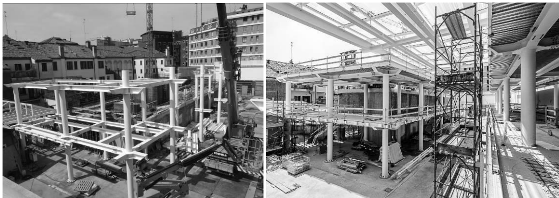
Fasi di cantiere Galleria Barcellona, Mestre – foto: BIT Costruzioni spa
