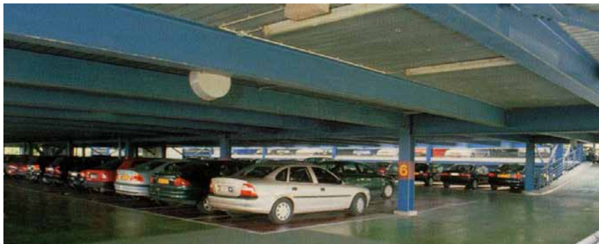
Figura 4 - Esempio di parcheggio aerato realizzato in Lussemburgo
